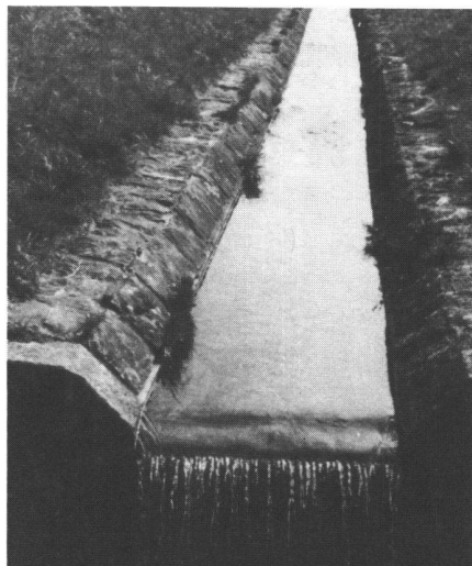
Altes Gerinne vor Ausbau
