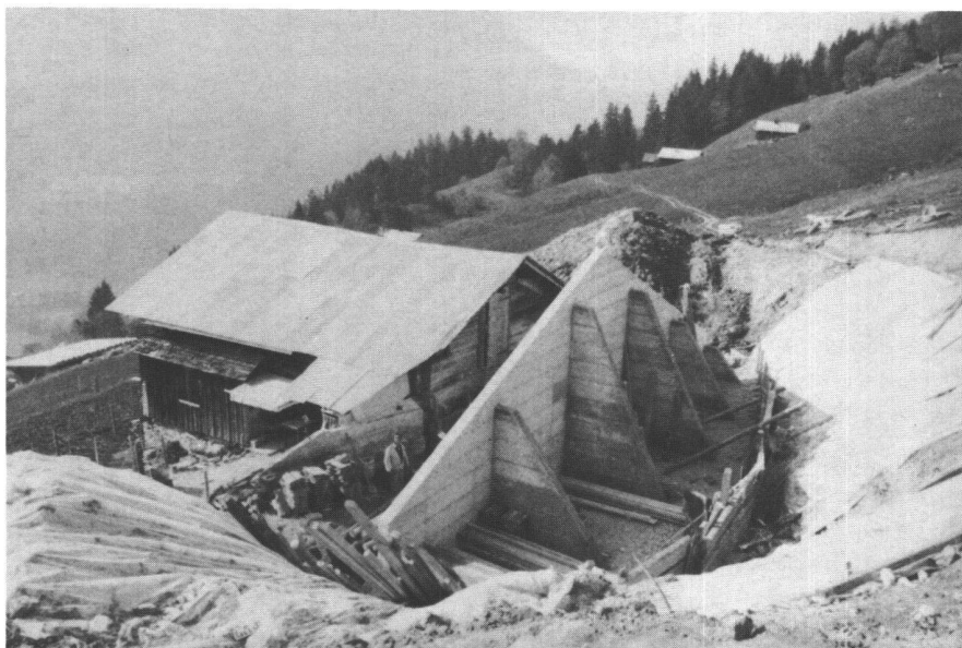
Fig. 2: Fort de protection d'un chalet situé dans un couloir d'avalanche.
