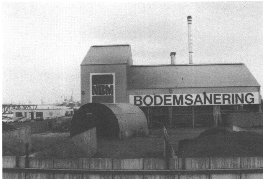
Abb. 4: Bodensanierungsfirma in Holland. Werden in der Schweiz in den kommenden Jahren ebenfalls zahlreiche solcher Firmen gegründet werden?
