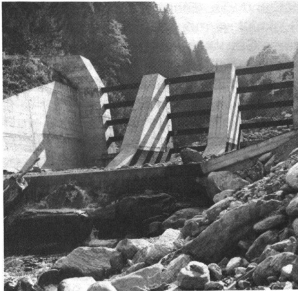
Abb. 1: Balkensperre im Sugadinbach-Galguel, Gemeinde St. Gallenkirch.
