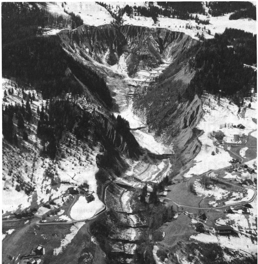
Abb. 2: Gesamtansicht des Schesatobels in der Gemeinde Bürserberg.
