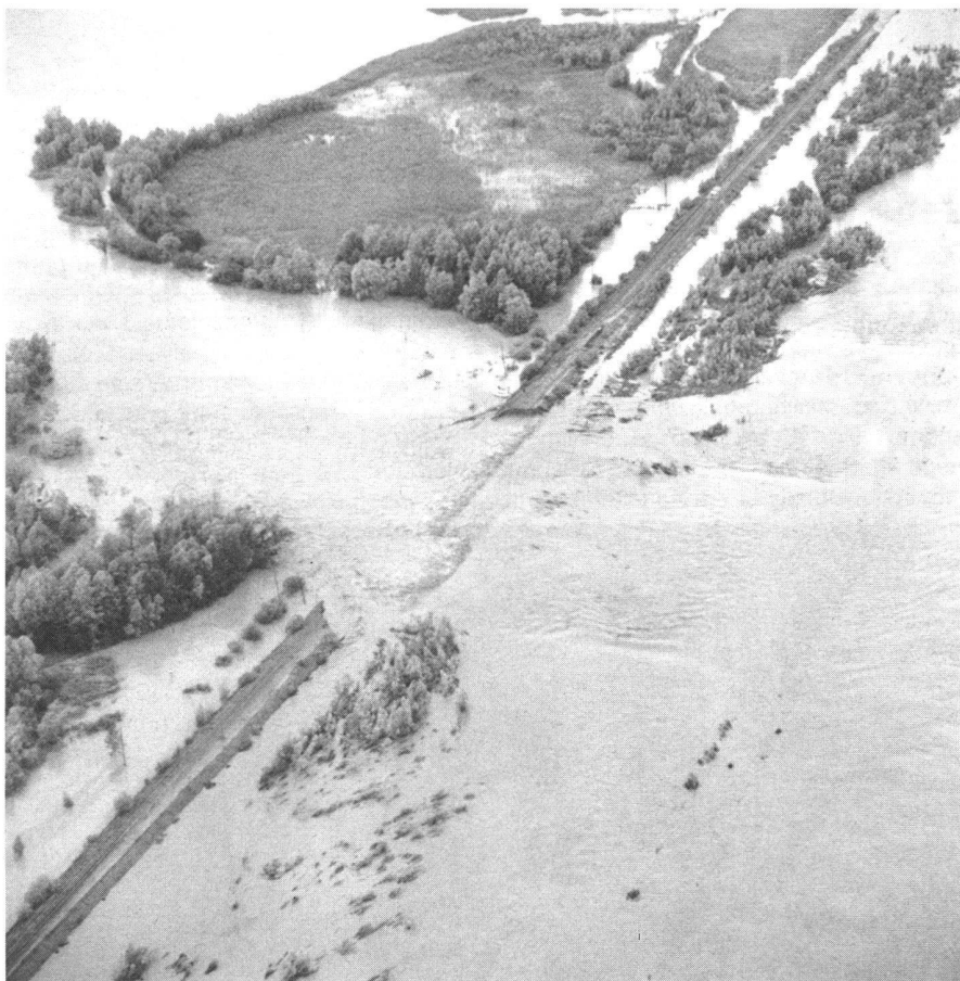
Abb. 8: Bruch des linken Hochwasserdammes im Bereich der Neuen Rheinmündung (Foto: Thorbecke).
