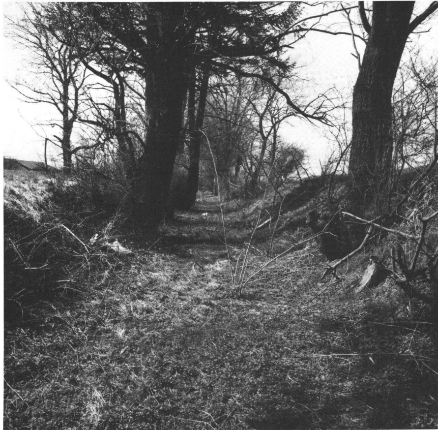
Abb. 1: Durch Grundwasserabsenkung ausgetrocknete Fließgewässer, heute durch Einleitung von Rheinwasser wieder bewässert.
