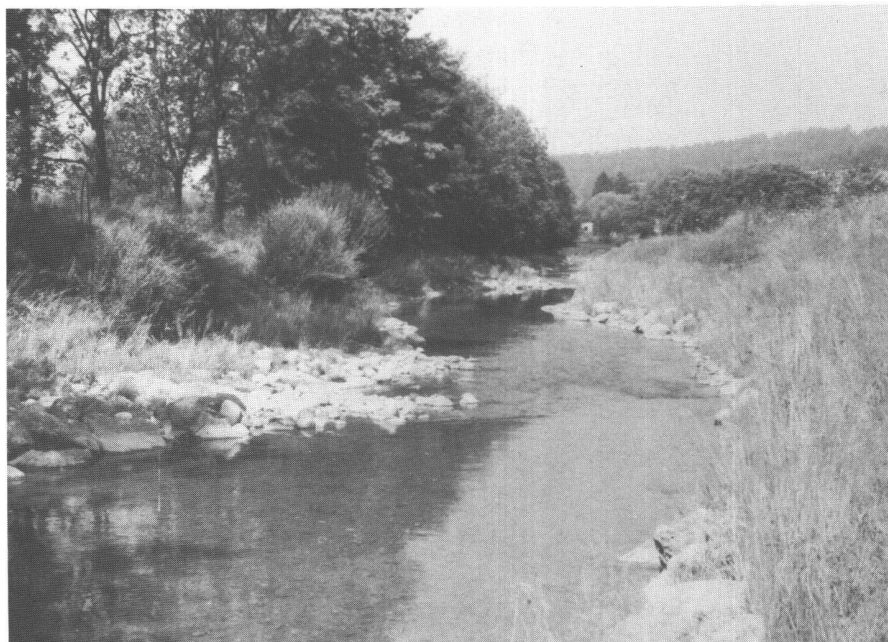
Abb. 6: Der neu ausgebaut Abschnitt des Steinenbaches bei Uznach.
