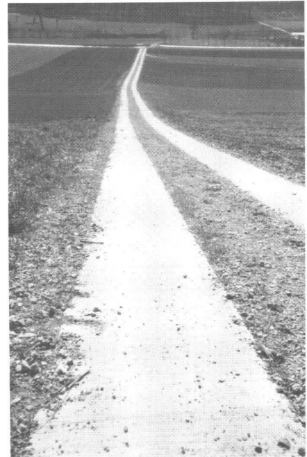
Abb. 5: Betonspurweg ein Jahr nach der Erstellung.
