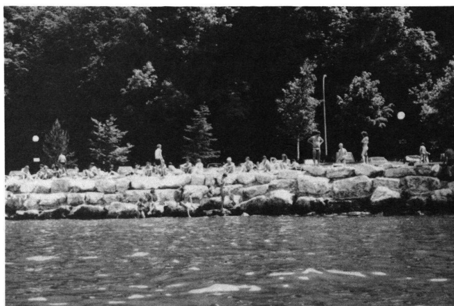
Abb. 9: Aufschüttung einer Flachwasserzone und Uferabschluss durch Blockwurf (Stansstad).
