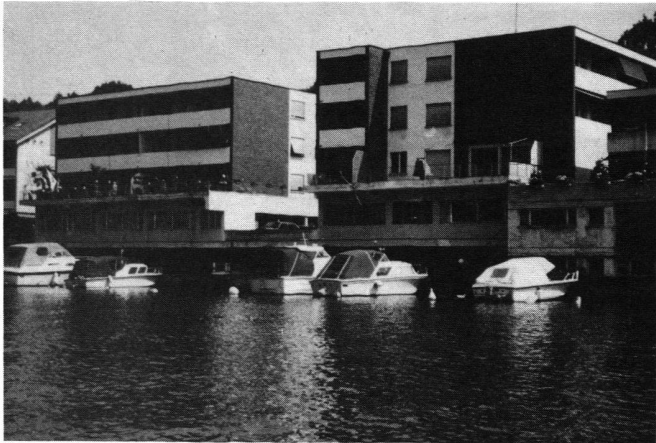
Abb. 8a: Zerstörung der Seeufer durch Wohn- und Ferienapartements mit Bootshallen und Bootsstandplätzen (Küssnacht).
