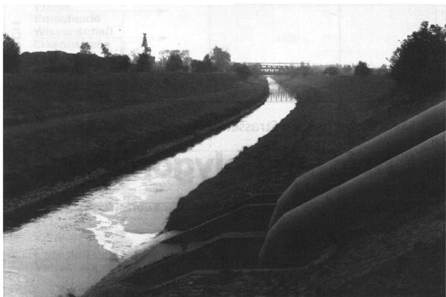
Abb. 1: Abwassereinlauf in die Emscher, die im Rahmen der IBA Emscher Park ökologisch umgestaltet werden soll (Foto: IBA Emscher Park).
