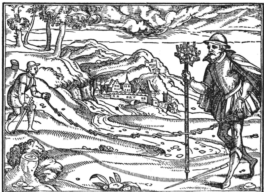
Abb. 10: Landmesser mit Kreuzvisier und Messkette, 1579.
