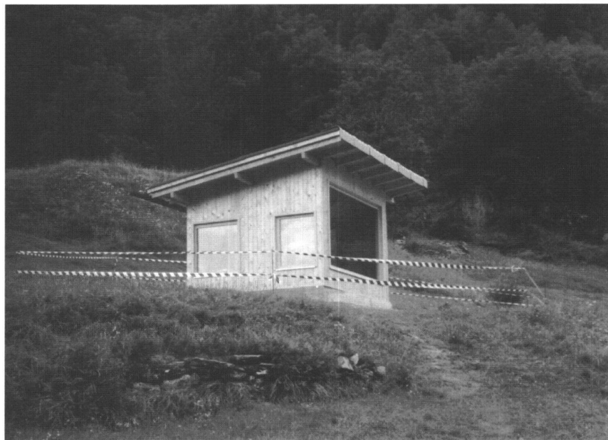
Abb. 4: Messhäuschen mit Fenster aus Floatglas.
