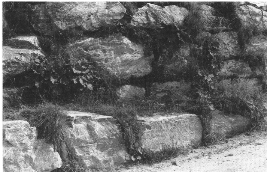
Abb. 7: Blockwürfe werden vorzu mit anstehendem Oberbodenmaterial verfüllt zur sofortigen Inbesitznahme durch die örtliche Vegetation.
