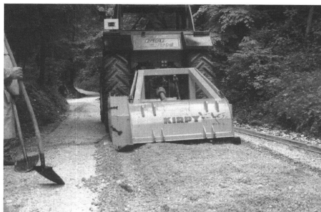
Fig. 3: Démonstration d'un concassage mobile.
