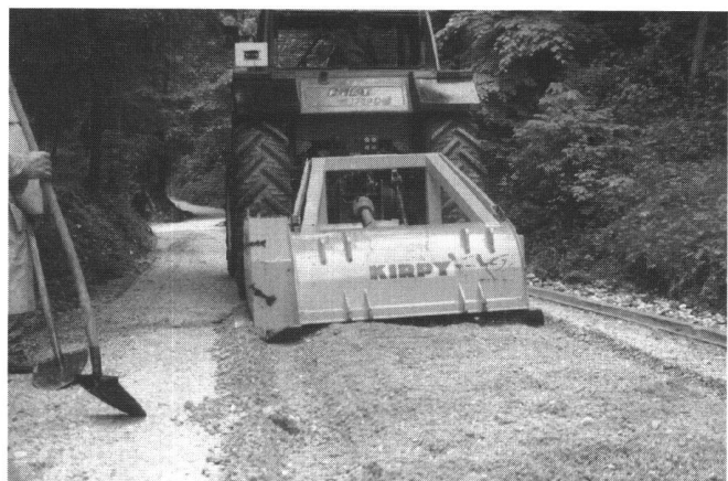
Fig. 3: Démonstration d'un concassage mobile.
