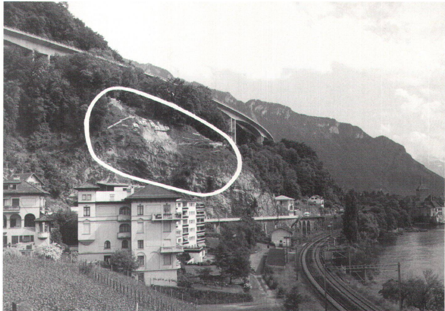
Abb. 1: Die Idylle trägt: Kurz vor Pfingsten hat sich hier in Montreux/Veytaux beim Château de Chillon am Genfer See ein ca. 100 Kubikmeter grosser Teil des Hanges über dem Felsen gelöst. Das weisse Oval zeigt das mit dem Leica System APSWin überwachte Gebiet. Rechts im Hintergrund über dem Wasserschloss von Chillon erkennt man die Dents-du-Midi (3257 mü.M.), wichtige Zeugen der Vermessungsgeschichte.
