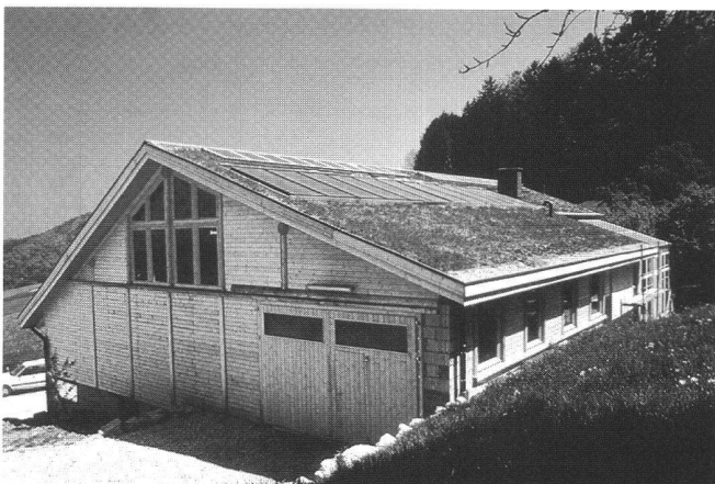
Abb. 1: Auf das begrünzte Süddach des Wohnhauses wurden 36 m 2 thermische Kollektoren montiert (Fotos: Eric de Lains-ecq).
