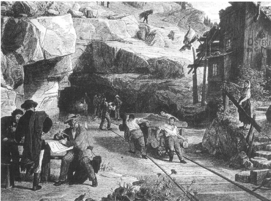
Abb. 2: Szene am Südportal des Gotthardtunnels während der Bauarbeiten.
