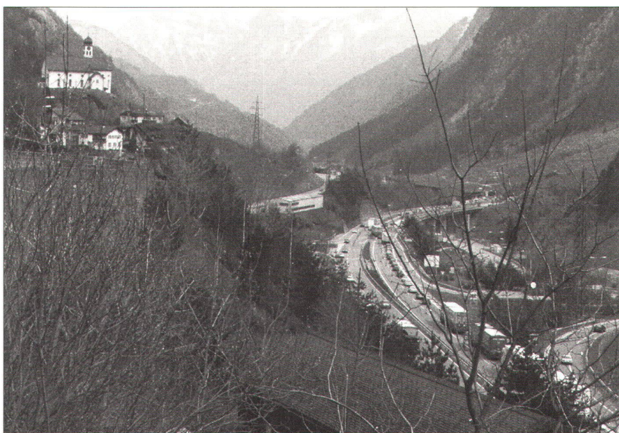
Abb. 2: ...und nahmen die Situation vor Ort in Augenschein, ...
