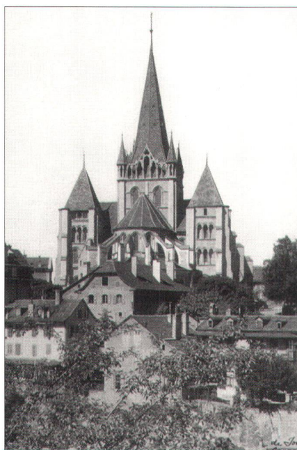
Fig. 1: Vue extérieure de la Tour-lanterne.
