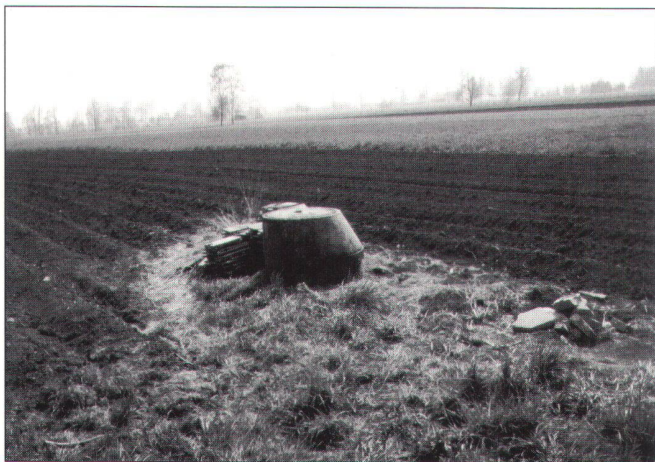
Abb. 4: Werksversagen sekundärer Art: Humuszehr, Höhenverlust, Durchlässigkeitsverminderung.
