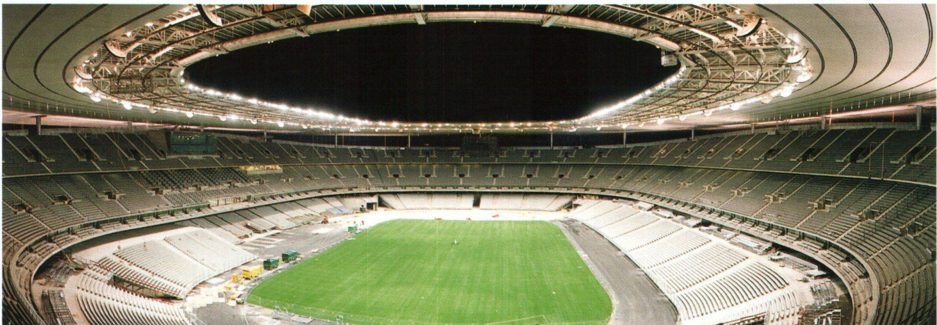
Abb. 3: Die untersten Tribünenränge sind mobil. Bei Leichtathletik-Veranstaltungen geben sie die Rennbahnen und die Sprunggruben frei. Bei Konzerten haben über 100 000 Zuschauer Platz.
