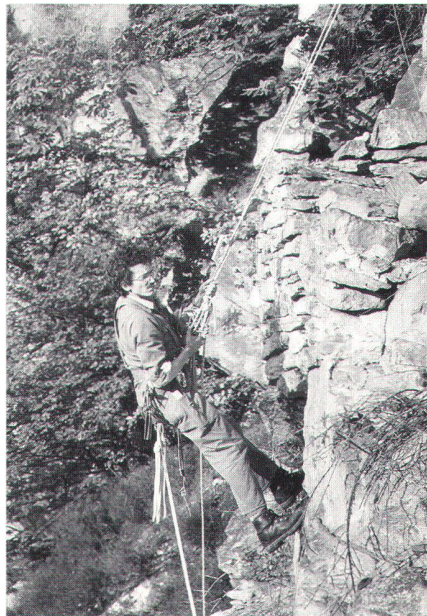
Abb. 1: Vermessung einer Höhlungsburg in den Felswänden über Malvaglia TI; die Mauer in der Bildmitte ist eine sog. Traverse zum Schutz gegen Kletterangriffe auf der Rückseite der Burg (Photo L. Högl).
