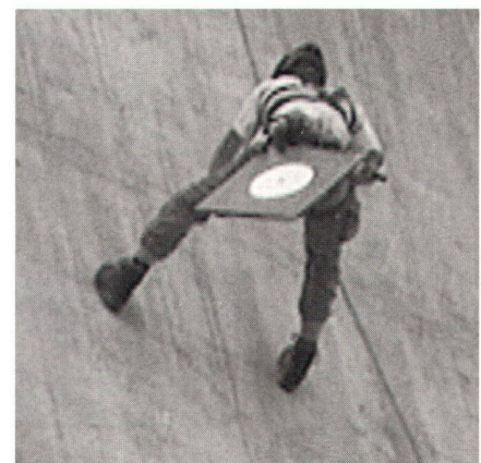
Abb. 2: Anbringen der Zielmarken an der Staumauer.
