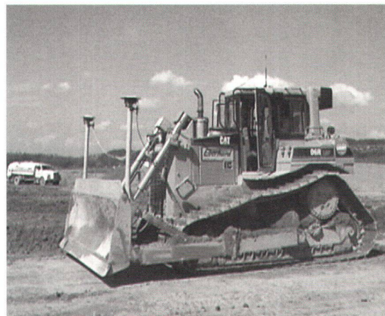
Site Vision. Trimble GPS-Maschinensteuerung Flughafen Zürich
