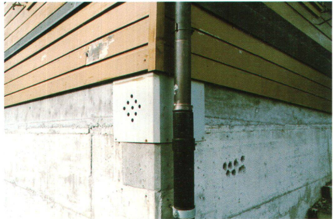
Abb. 3: Ausgerichtetes Gebäude am Wägitalersee (verdeckte Aussparung für hydraulische Presse).
