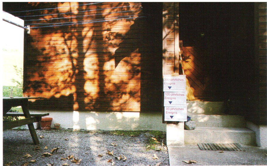
Abb. 1: Überschwemmungskoten an einem Gebäude.
