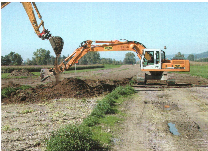
Abb. 3: Rekultivierung des Grabenbereiches. Der lockere, schüttfähige Humus wird mit zwei Bagger eingebracht. Die Maschinen stehen auf Baggermatratzen weil der Unterboden nach einem Niederschlag noch feucht ist. Sofern alle Erdarbeiten bei guten Bedingungen ausgeführt werden konnten, ist ein Vorbegrünen des eingebrachten Unterbodens nicht notwendig (Foto M. Achermann).
