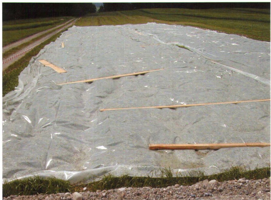
Abb. 2: Es stehen auch «billige» Massnahmen mit örtlich grosser Wirkung zur Verfügung. So das Abdecken kurzer Strecken mit Folie, um den abgetrockneten Boden vor einem Gewitterregen und der damit verbundenen Vernässung zu schützen (Foto Gérald Richner).
