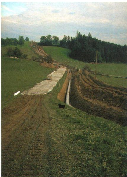
**Abb. 2:** Die 50 cm mächtige Kiespiste kommt auf beinahe allen Böden zum Einsatz. Nur auf sehr schnell abtrocknenden und besonders tragfähigen Böden wird keine Piste geschüttet, dort wird direkt auf der Grasnarbe gefahren (Foto M. Achermann).
