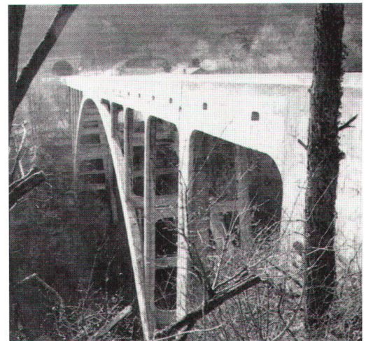
Abb. 1: Gueuroz-Brücke bei Martigny (VS), 1934.
