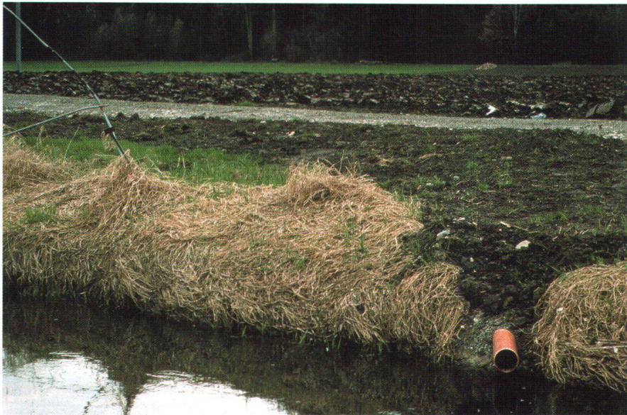
Abb. 2: Beim kulturtechnischen Wasserbau steht die Urbarmachung des Landes längst nicht mehr im Vordergrund. Heute ist die Bodenentwässerung Bestandteil eines integralen Managements des Landschaftswasserhaushalts zur Erhaltung bzw. Förderung ökologischer, wirtschaftlicher und gesellschaftlicher Werte der Landschaft. Dabei müssen nicht nur hydraulische Aspekte berücksichtigt werden, auch die Fragen des Stofftransports im Bodenwasser spielen eine wichtige Rolle. (Foto: Institut für Kulturtechnik ETHZ.)
