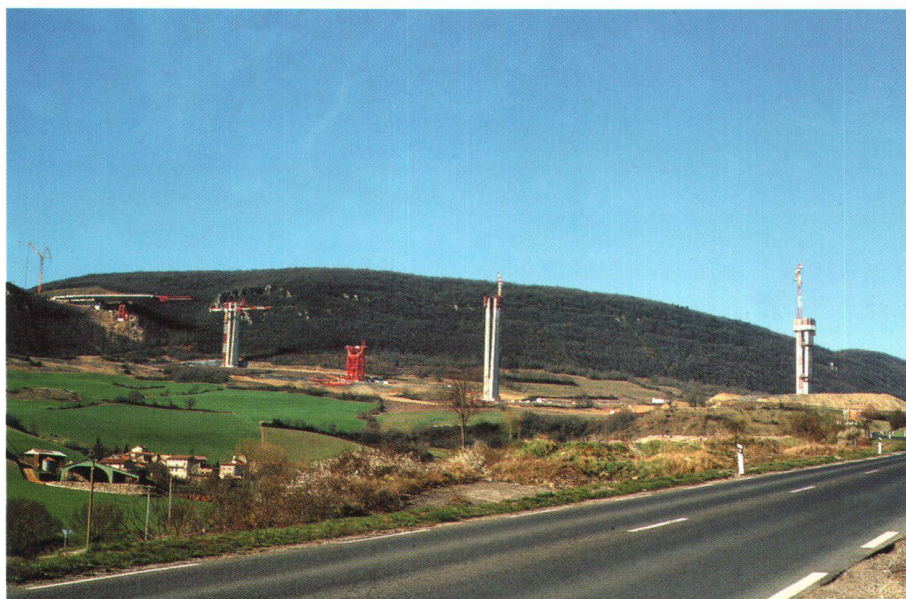
Abb. 2: Die verschiedenen hohen Brückenpfeiler sind in den oberen 90 Metern gabelförmig betoniert. Auf dem linken Bild schiebt sich von der südlichen Rampe bereits die erste Fahrbahn-Profilplatte Richtung Leererüst und Pfeiler P7. Ihre jeweilige Position und die gesamten Betonierarbeiten werden mit Leica GPS-Vermessungssystemen direkt eingemessen. Die vor Baubeginn fest installierte Referenzstation Leica GPS 530 RTK (Bild rechts) sendet für die differenzielle Messung im gesamten Baugelände rund um die Uhr Korrekturdaten aus. Dies ermöglicht es den Baufachleuten, mit ihren mobilen Leica GPS-Systemen die Betonverschalungen millimetergenau einzumessen. Foto: Leica Geosystems.
