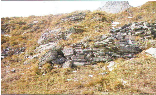
Abb. 6: Kleine Stützmauer des Weges an wenig schwieriger Stelle, letzter Überrest der künstlichen Bauten.
