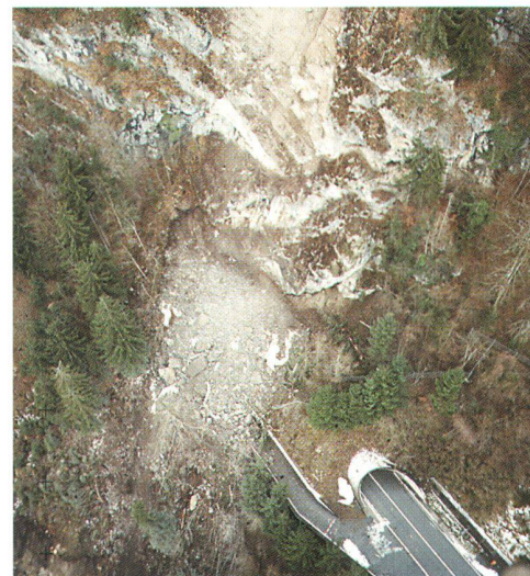
Abb. 2: Zerstörung des Tunnelportals durch einen Felssturz bei Iseltwald.
