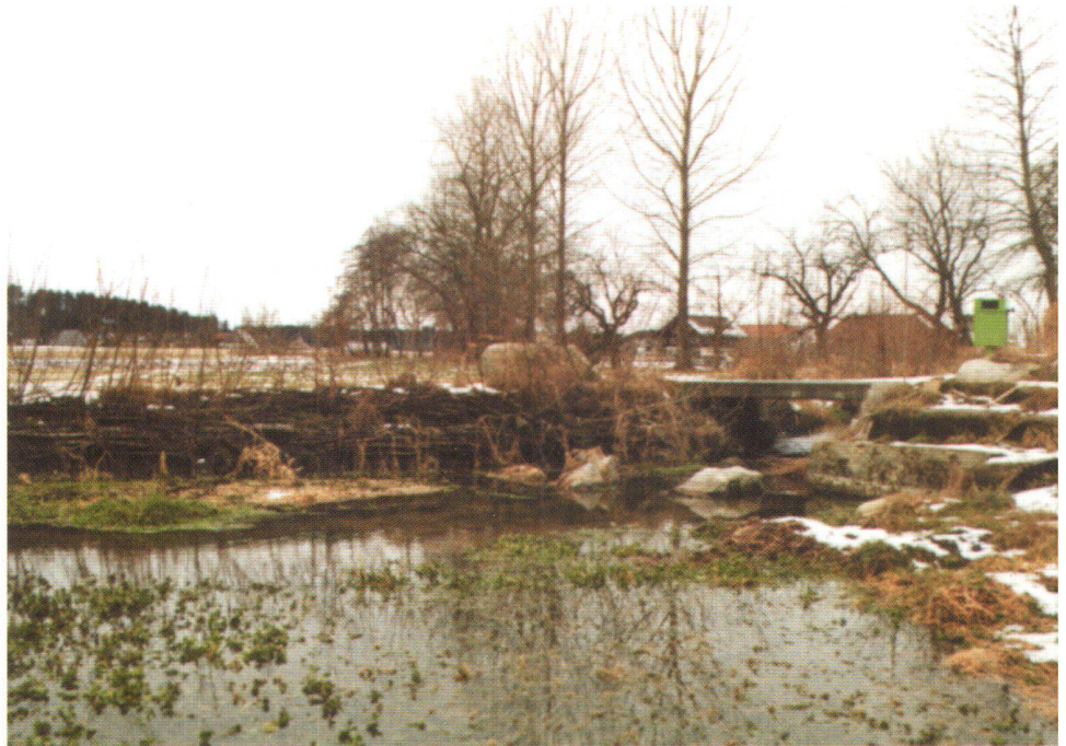
Abb. 3: Naturnaher Geschiebesammler am Dorfbach bei Hindelbank (Kanton Bern). Dieses Beispiel entspricht dem Idealbild eines modernen und naturverträglichen Geschiebesammlers im Mittelland.
