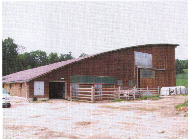
Abb. 9: Die neue Scheune für das Milchvieh der Betriebsgemeinschaft zweier Landwirte ist hoch beim Futterlager und niedrig im Stallteil. Mit dem optimalen Gebäudequerschnitt können Kosten gespart werden.
