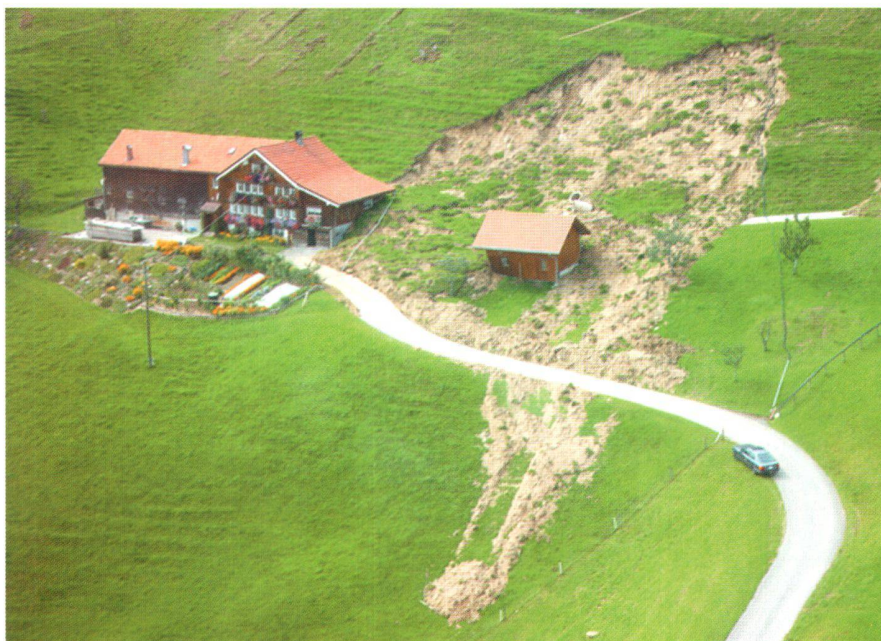
Abb. 10: Urnäsch AR: Durch heftige Niederschläge verursachte Erdrutsche gefährden die Gebäude und unterbinden die Zufahrt.
