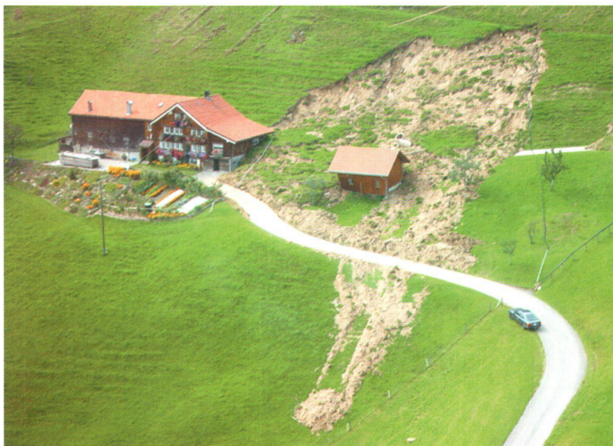
Abb. 10: Urnäsch AR: Durch heftige Niederschläge verursachte Erdrutsche gefährden die Gebäude und unterbinden die Zufahrt.
