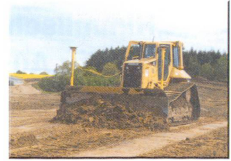
Caterpillar Raupe D6N mit installiertem SiteVision GPS.
