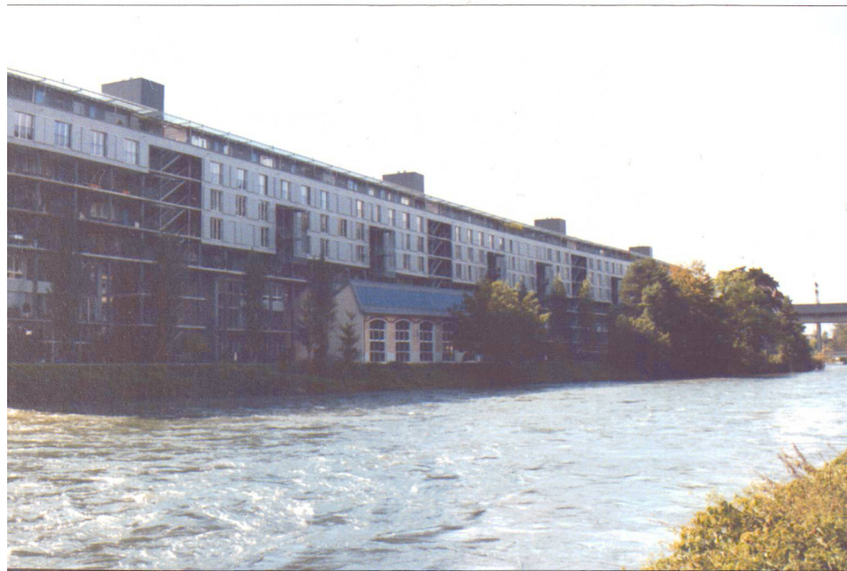
Abb. 2: Altlastensanierung Zürich West.
