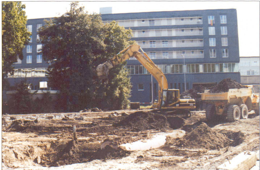
Abb. 1: Altlastensanierung Zürich Nord.
