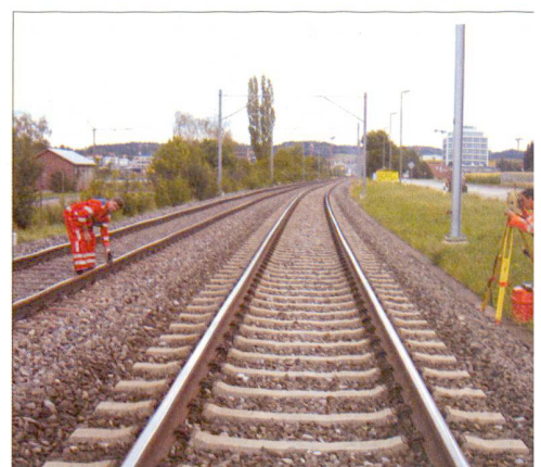
Abb. 6: Freie Stationierung, Kontrolle Gleislage.
