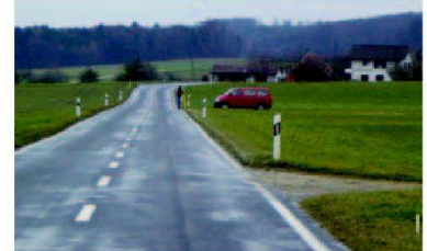
Keine korrekte Sicherung gegenüber dem Strassenverkehr.
