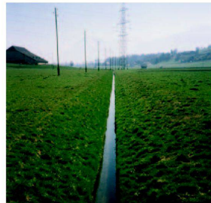
Abb. 1: Vor der Renaturierung: Schnurgerader Limpachkanal in einer Beton-Halbschale, steile Grasböschungen ohne jegliche Bestockung.
