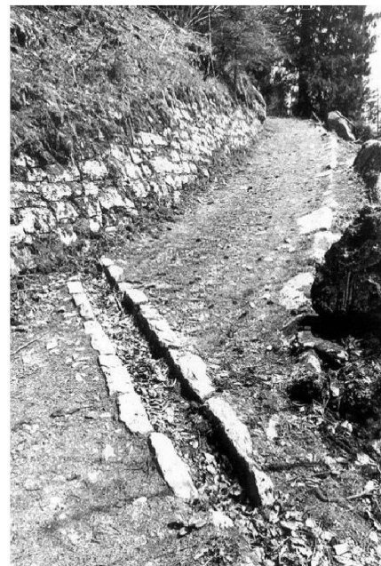
Abb. 1: Gemeinde Brienzwiler, vom Bund subventionierter Alpweg Wylervorsass, 2500 m lang, Ausführungskosten Fr. 18 200.-, ausgeführt 1896; heute historisches Objekt von nationaler Bedeutung (BE 162) wegen seiner überdurchschnittlichen Substanz.
