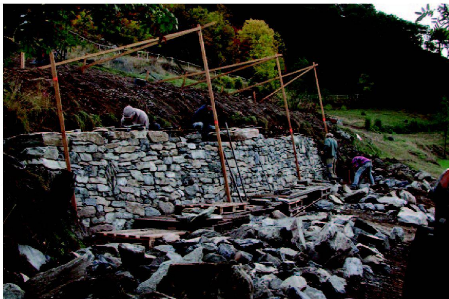
Abb. 3: Trockenmauer wird wieder aufgebaut.
