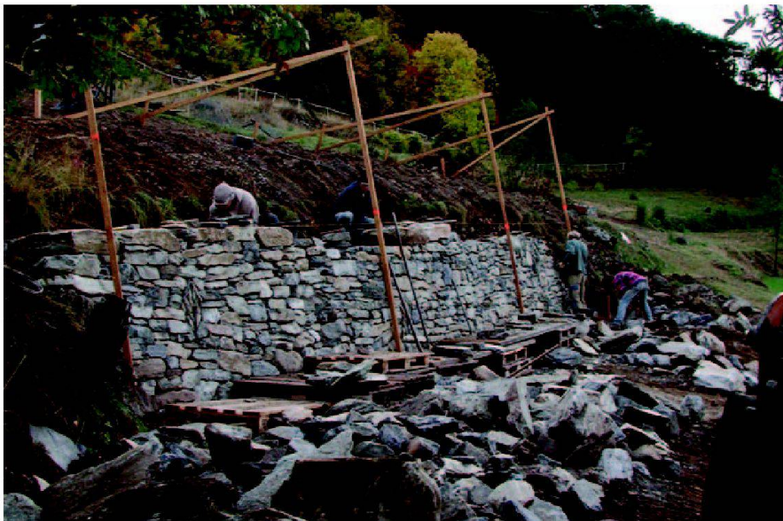
Abb. 3: Trockenmauer wird wieder aufgebaut.
