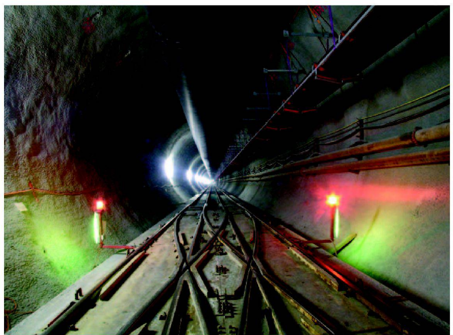
Abb. 5: Betonierete Sohle mit Baugelaise in Amsteg.
