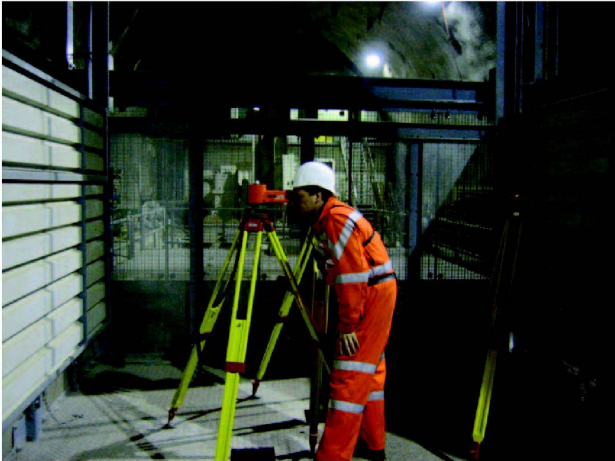
Abb. 4: Optische Lotung im Schacht 2 in Sedrun.
