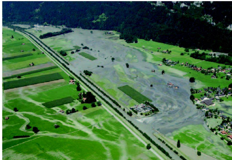
Abb. 5: BE Meiringen: übersaartes Kulturland mit beschädigten Güterwegen.
