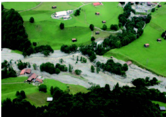
Abb. 6: GR Klosters: Kulturlandverlust; zerstörte Gebäude und Güterwege.
