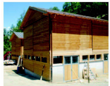
Abb. 3: Neue Ställe am Standort der alten.
