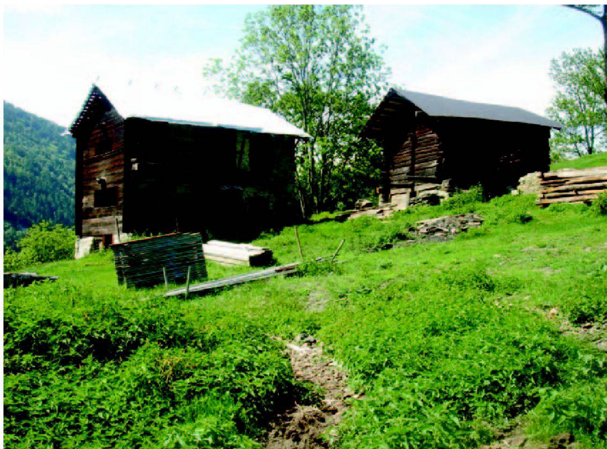
Abb. 6: Alte Gebäude werden für Agrotourismus renoviert.
