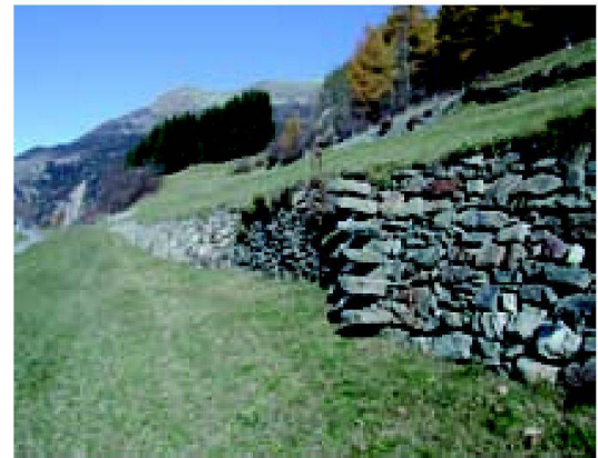
Abb. 3: Güterzusammenlegung Brusio-Viano: Trockenmauern, 2003 (Quelle: René Weber, ASV-BLW).
