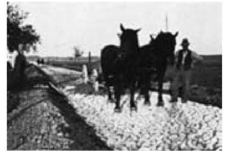
Abb. 2: Güterzusammenlegung in Utzenstorf: Wegebau, 1930.
