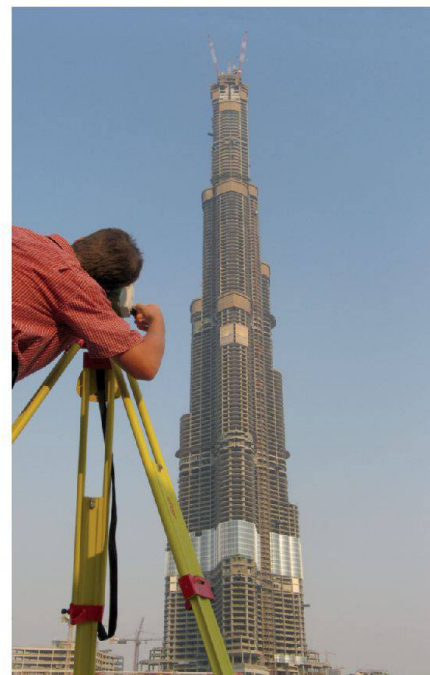
Abb. 1: Mit über 512 m ist der Burj Dubai das höchste Gebäude der Welt.
