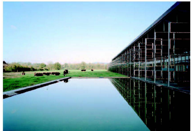
Abb. 2: Werkerweiterung der Fensterfabrik Hagendorn (Zug).
