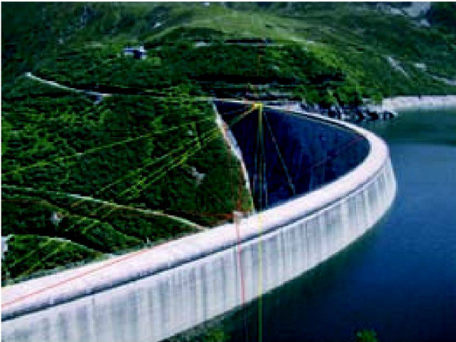
TPS-Monitoring im Gotthardgebiet.
