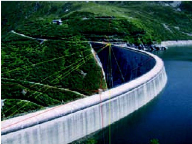
TPS-Monitoring im Gotthardgebiet.
