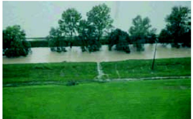
Abb. 3: Rechter Hintergraben, Hochwasserereignis August 2005: Ein Dambruch hätte mit grosser Wahrscheinlichkeit auch den Bruch des Hauptdammes zur Folge.
