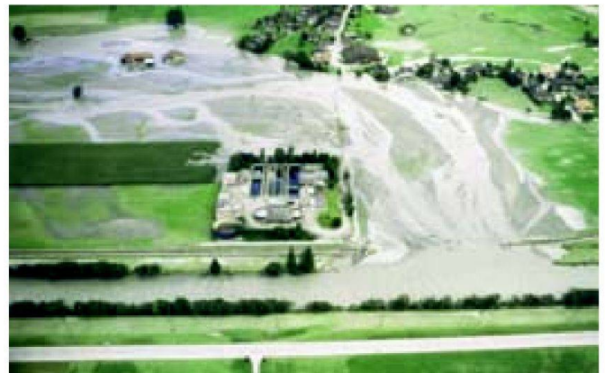
Abb. 5: Unterbrochene Bahnverbindung und überschwemmte Flussebene im August 2005 nach einem Dammbbruch am Oberlauf der Aare bei Meiringen BE.
