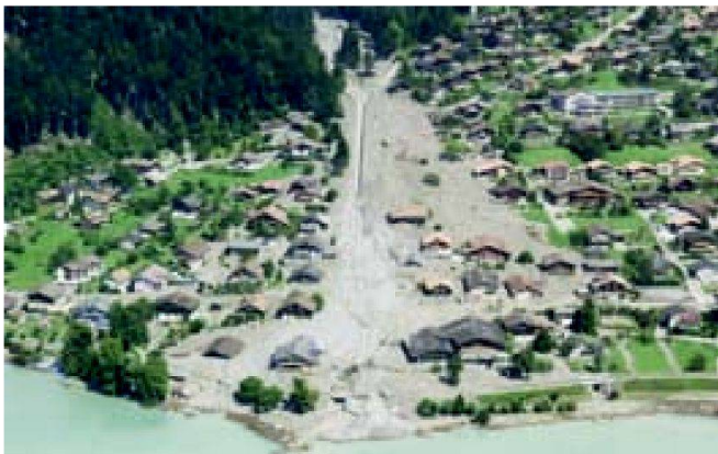
Abb. 4: Zerstörung eines Dorfteils von Brienz BE durch einen Murgang des Glyssibachs während der August-Unwetter 2005.
